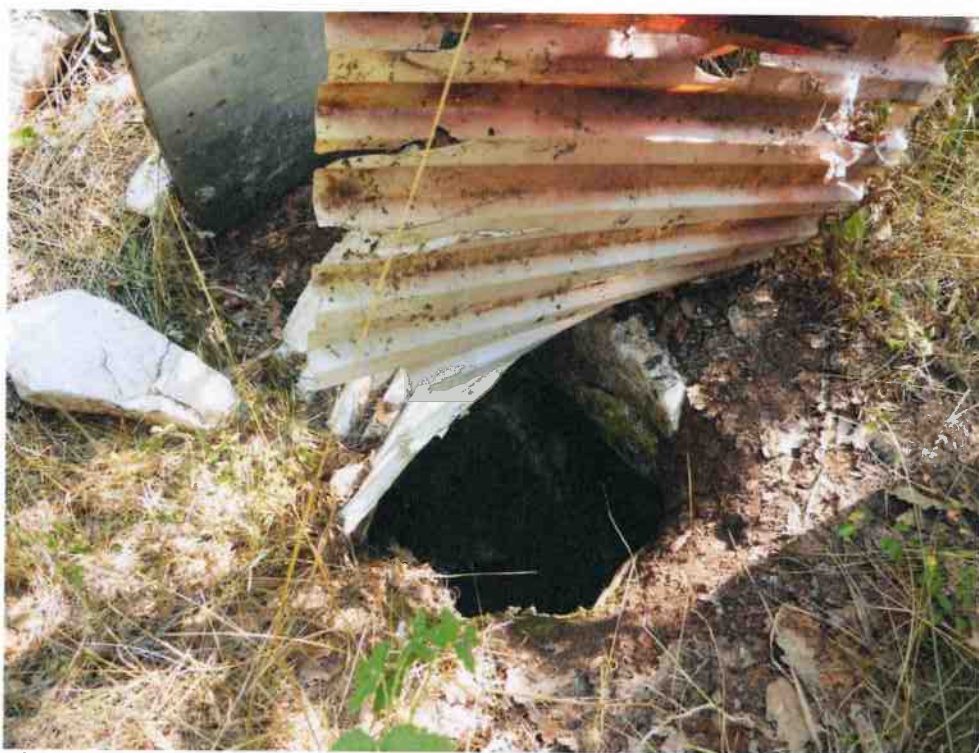
Photo 17 : aven "Décharge" recouvert par une plaque en métal
