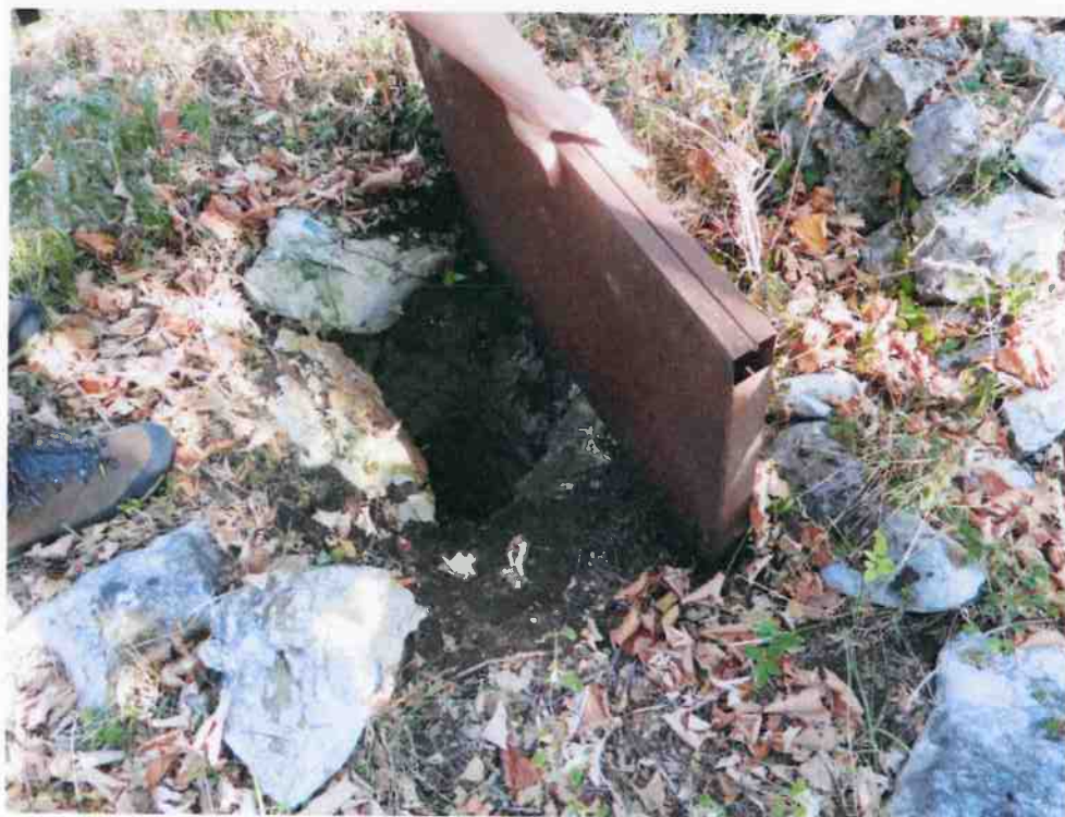
Photo 18 : aven "Pastaga" recouvert par une plaque en métal
